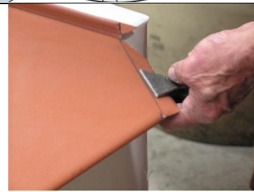
3) Gör omvik: för att få ett öppet omvik kan fliken justeras med plastklubba med ett ca 2mm inlägg i öppningen (håll till på ett arbetsbord, med skyddsunderlägg, se nästa bild)
