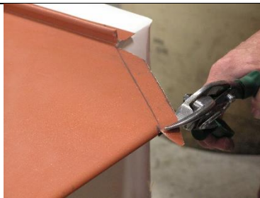
2 ) Kapa till fals & klipp flik för vinkelränna
